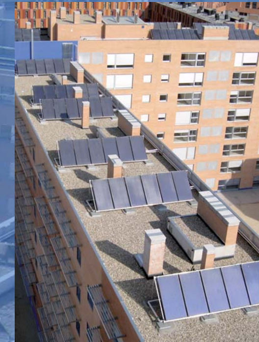
Paneles Solares en la cubierta
